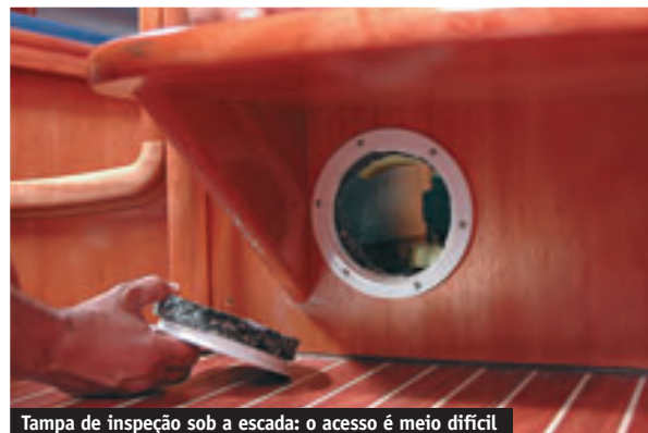
Tampa de inspeção sob a escada: o acesso é meio difícil
