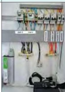
A instalação é feita com fios estanhados e codificados, o que é o ideal. Porém, as chaves gerais são do tipo faca, nada indicadas para barcos pois oxidam com facilidade e podem gerar faísca ao ser acionadas, gerando risco de incêndio.
