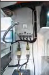
A instalação é caprichada e de acesso fácil. Chaves e baterias estão bem acondicionadas, livres da água. Há caixas de interrupção de corrente para o gerador e chillers de ar-refrigerado. Um sistema de jumping impede que os motores fiquem sem baterias.
